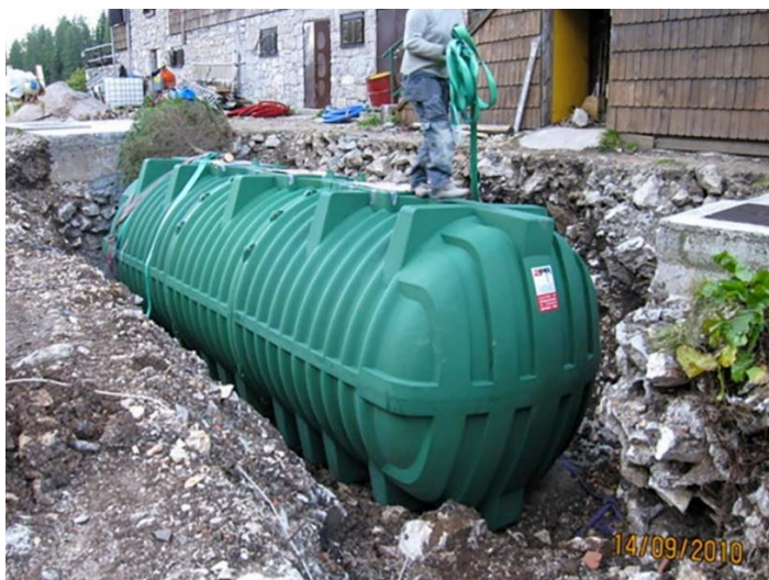
Slika 1: Vgradnja MKČN ob Koči pri Triglavskih jezerih
